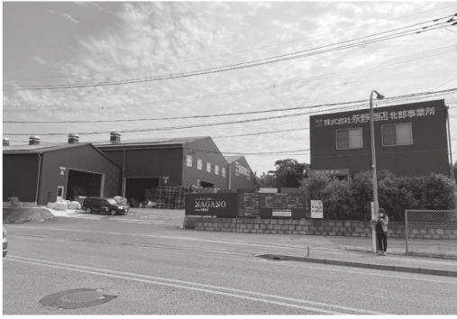
▲外壁工事などのリニューアルを施した北部事業所
